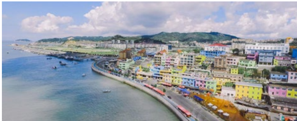
本行持续推广“乡村人居环境贷”，支持重庆、江苏、浙江、四川等地农村污水处理、村容村貌整体提升等项目。图为浙江温州分行支持开发建设七彩渔村，助推洞头海岛乡村人居环境提升。(浙江分行 供图)
