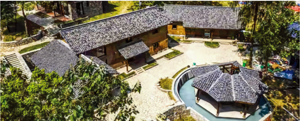
升级改造后的“下庄天路”景区
