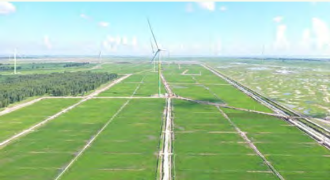
北京分行支持盐碱地改良项目。（北京分行 供图）
