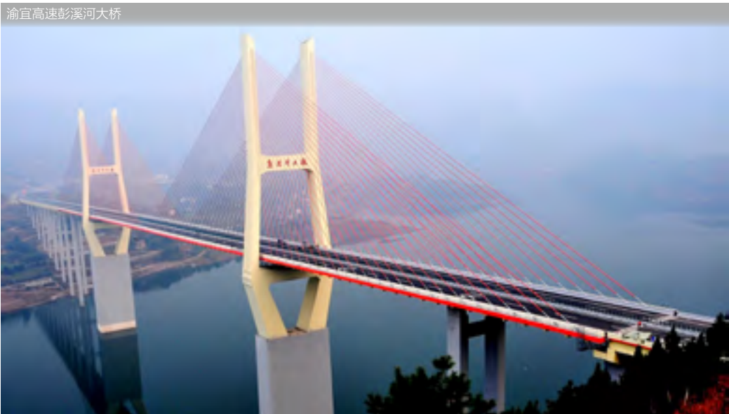
渝宜高速彭溪河大桥
